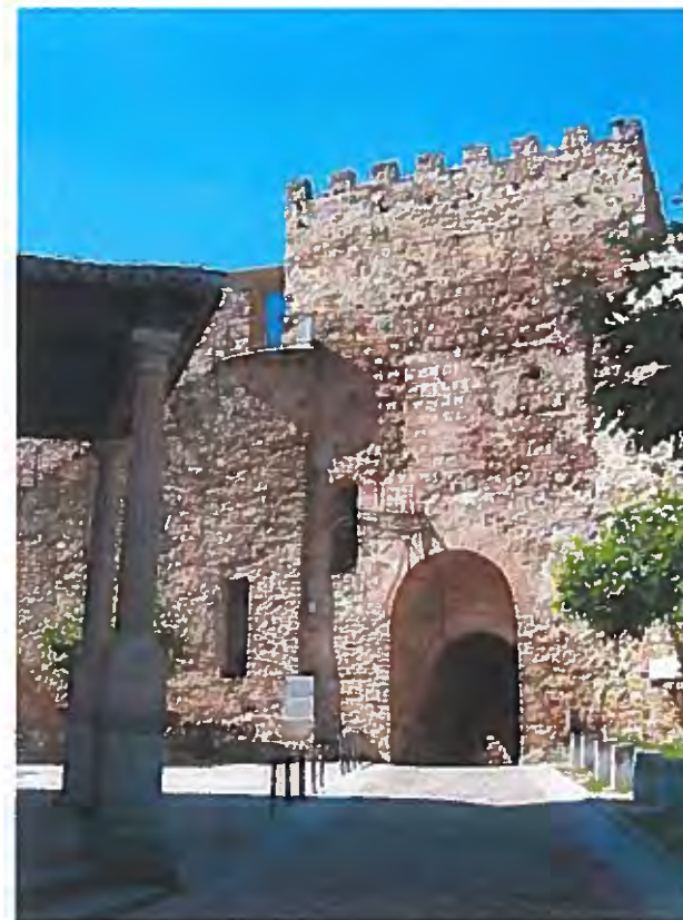
Vista de la desembocadura de la puerta desde el interior de la Villa
